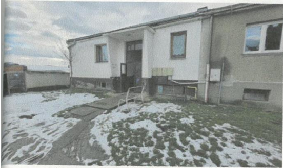
Pohľad predný obr.2.jpg
