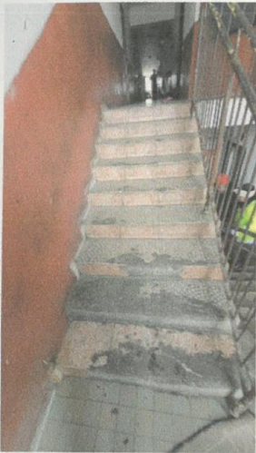
Schodisko na prízemie objektu.jpg
