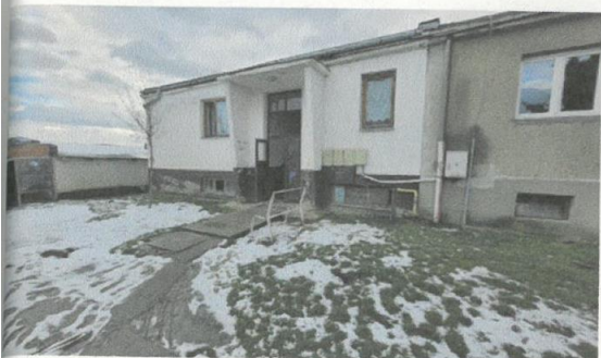
Pohľad predný obr.2.jpg
